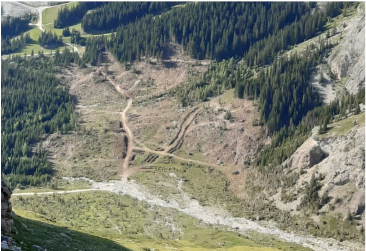
Photo prise après nettoyage
