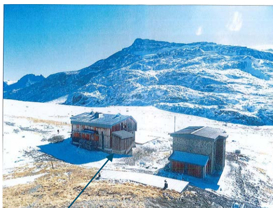
Nouvelles toilettes sèches sur la façade bord du nouveau refuge.
